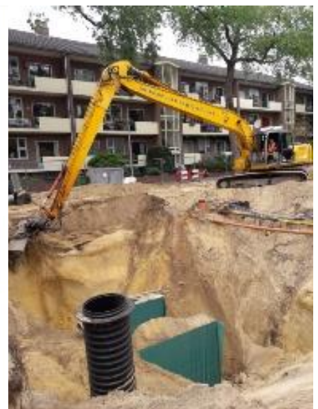
Aanleg infiltratievoorziening Laan 40-45
