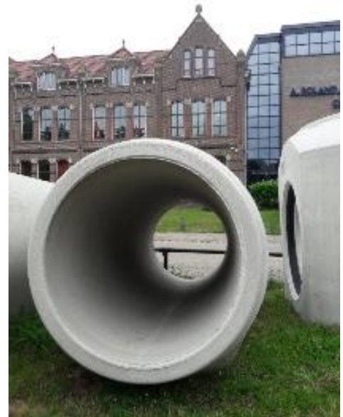
Rioolvervanging aan de Schuttersweg
